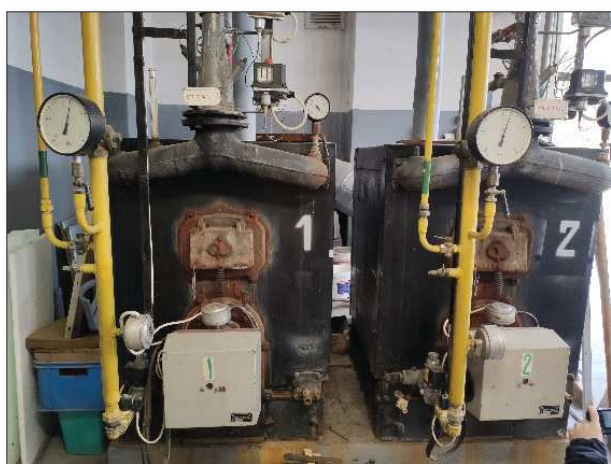
Stávaj. 2 ks kotle na ZP, jm. tep. výkon 83,5 kW
