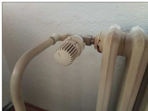
Radiátory jsou opatřeny term. vent. s term. hlavicemi
